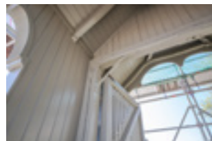
Bruksporten vid Verket under upprustning
